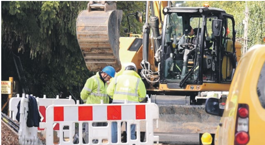
WIELKI PLAC BUDOWY
