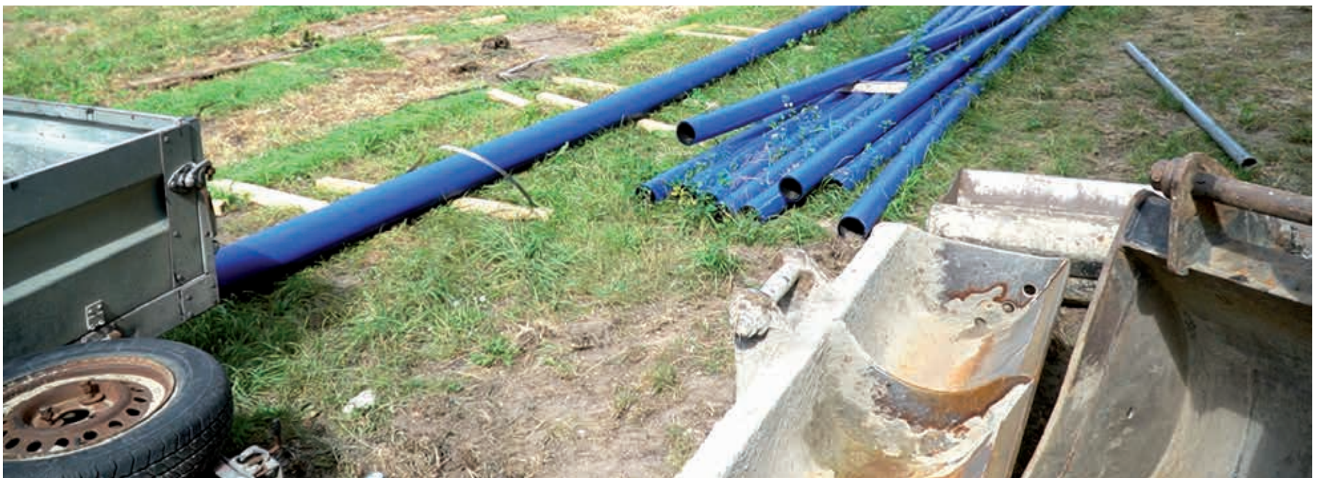
Sieć wodociągowa będzie miała ponad 3 km długości.
