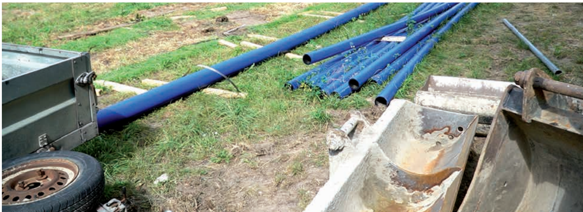
Sieć wodociągowa będzie miała ponad 3 km długości.
