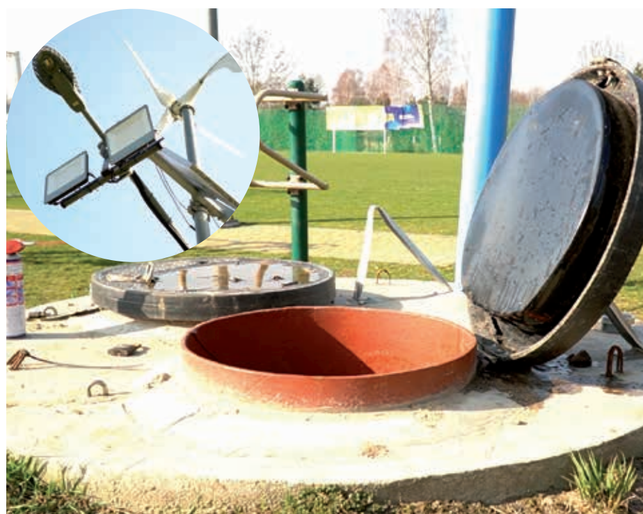
Studnia głębinowa, która ma 99 m głębokości, pomaga w nawodnieniu boiska.
