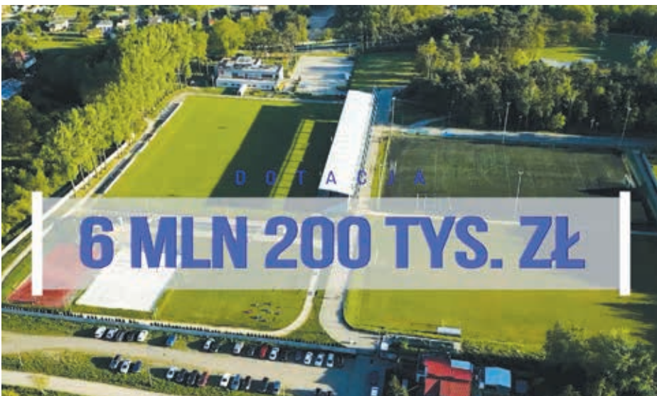
Modernizacja obiektów MOSiR
