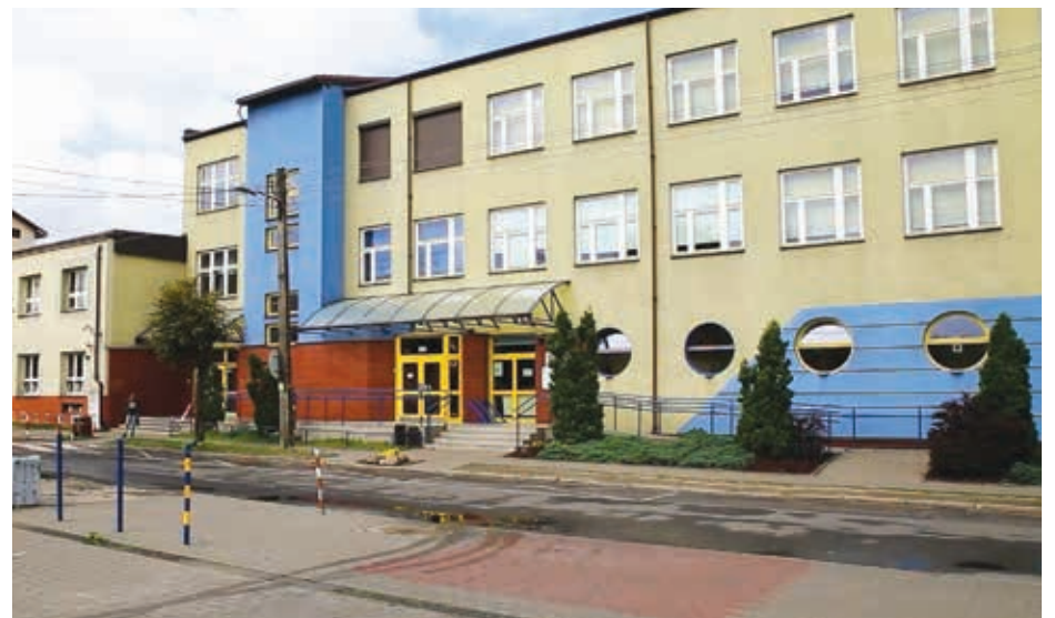
Montaż fotowoltaiki na budynku pływalni wskazywał kierunek w którym podąża gmina
