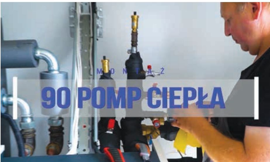
Realizacja programu rewitalizacji 103 kamienic i 90 pomp ciepła
