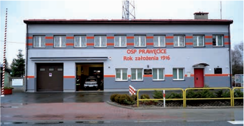
Strażnica OSP Prawęcice po termomodernizacji.
