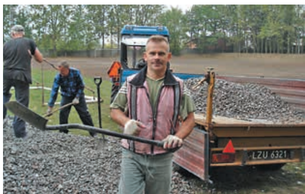
Arkadiusz Cichecki podczas prac prowadzonych na obiekcie.
