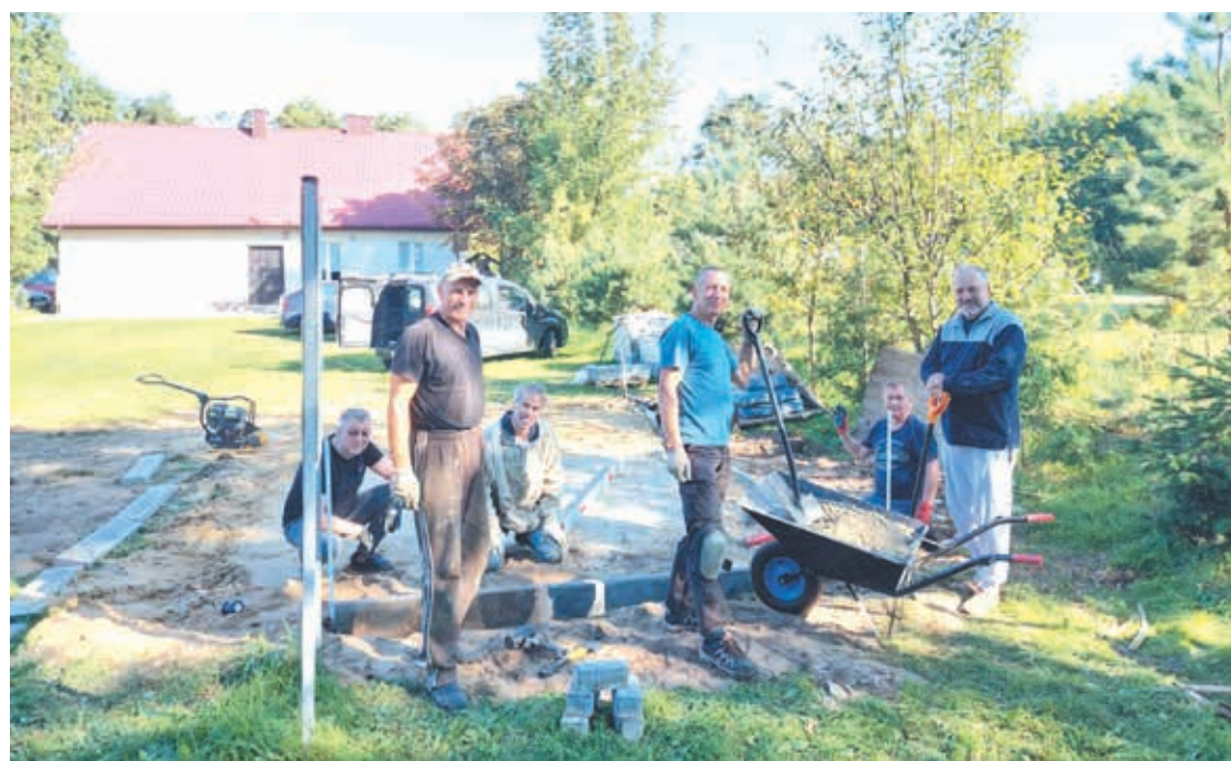
Mieszkańcy Krzywca podczas prac pod budowę altany.
