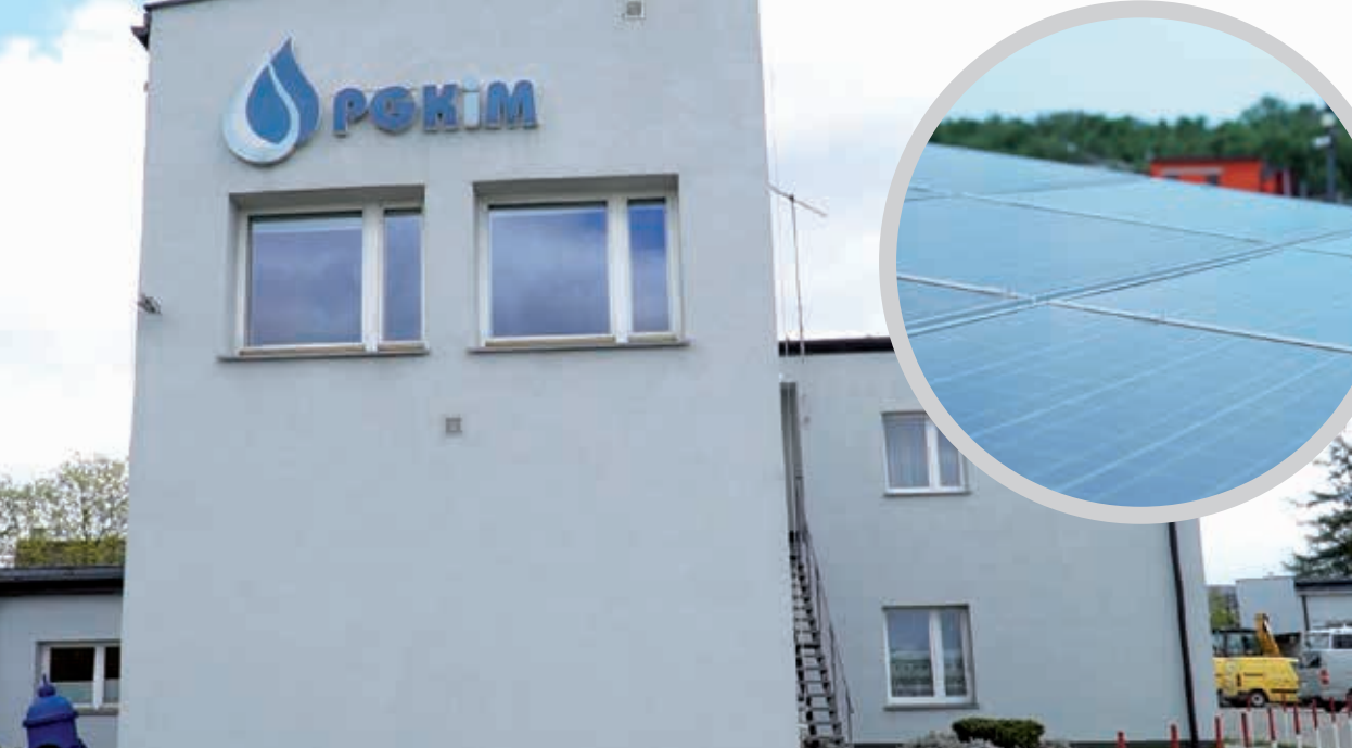
Panele fotowoltaiczne zasilą m.in. siedzibę PGKiM przy ul. 1 Maja.
