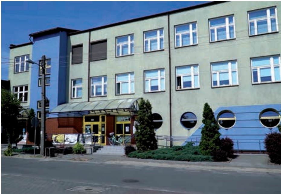
Na dachu pływalni „Olimpijczyk” zbudowano kolektory słoneczne.
