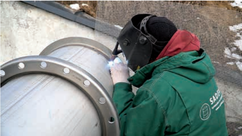
Wymiana rur wodociągowych na ul. 11 Listopada.
