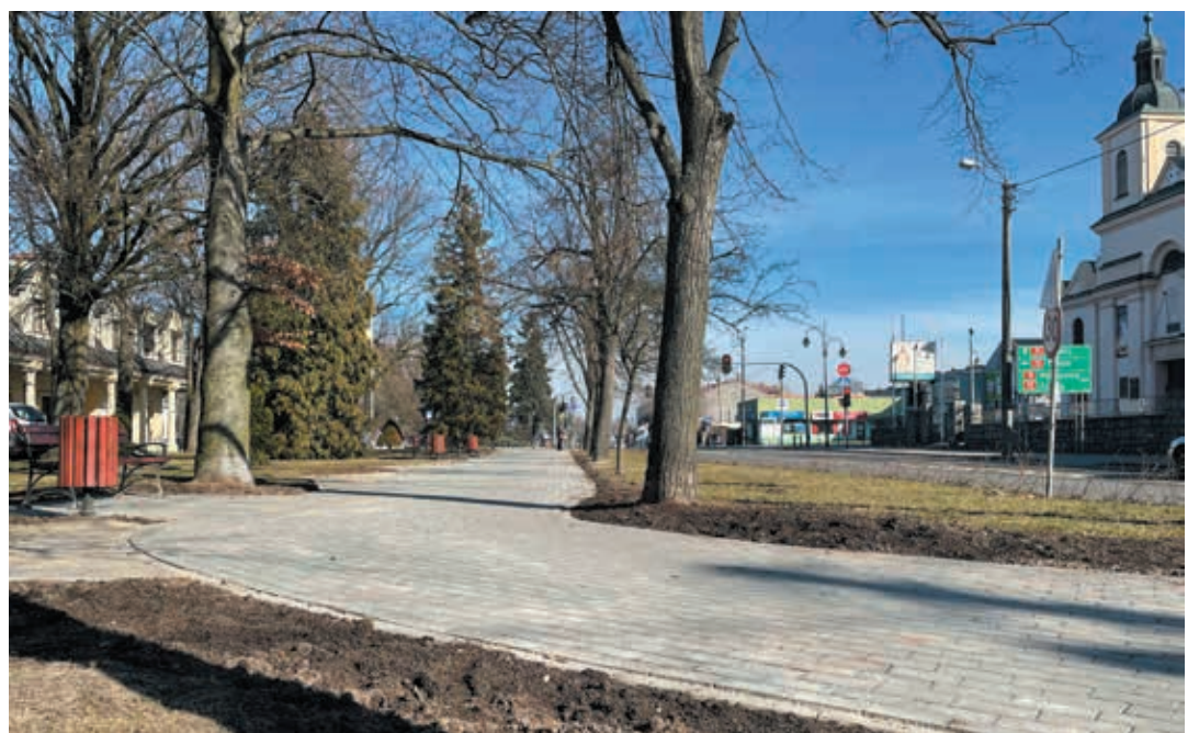
1 marca odbył się odbiór techniczny pierwszego etapu ciągu pieszo-rowerowego.
