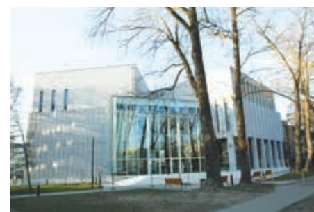
Nowa część budynku szkoły.
