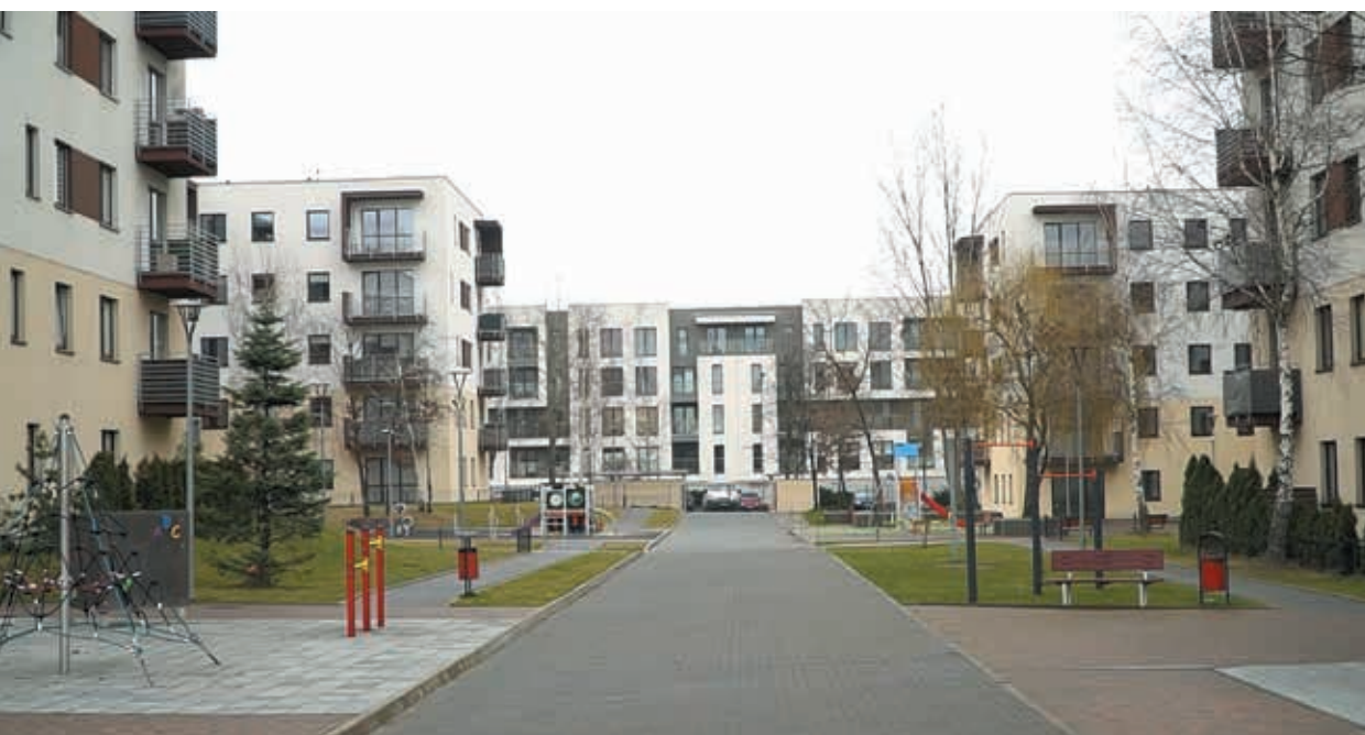
Osiedle bloków przy ul. Piłsudskiego.
