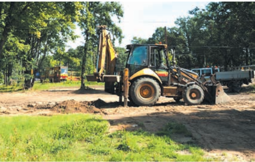
Prace ziemne w Kochanówce trwają już od lipca.
