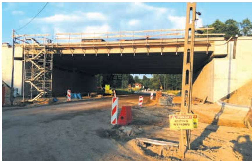
Budowa wiaduktu w rejonie ul. Klinowej
