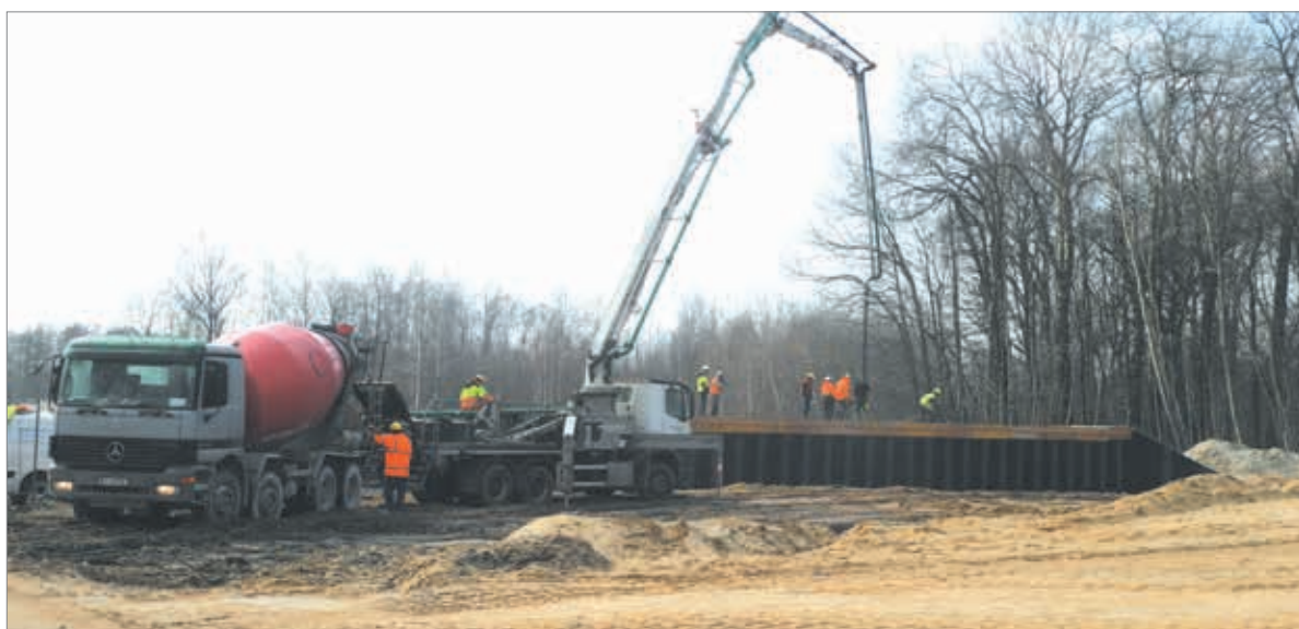
Najbardziej zaawansowana jest budowa wiaduktu przy ul. Aleksandrowskiej, Fot. Stecol
